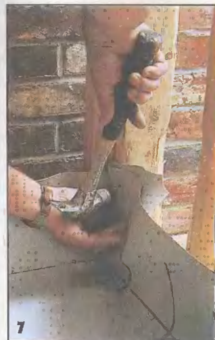
Прибейте складки к стене одним кровельным гвоздем каждую. Забивая по периметру остальные гвозди, не натягивайте пленку слишком туго
