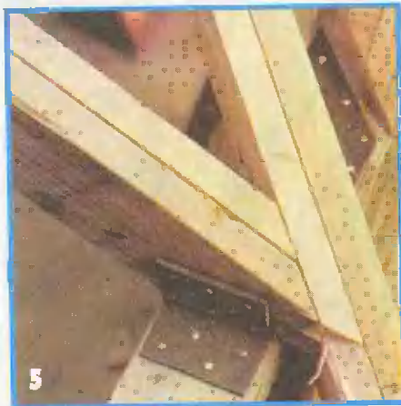
Маленькая страховка. Для усиления соединения крыши со стенами самые длинные из коротких стропил и врезные разжелобки скреплены стальными кронштейнами
