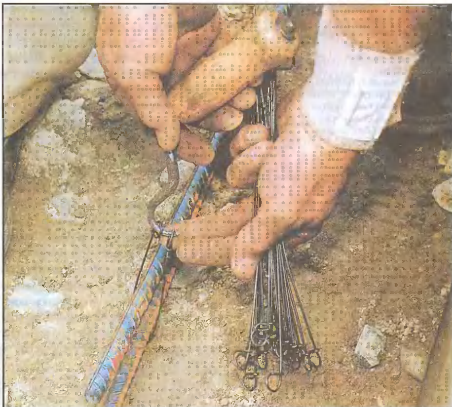
Арматуру фиксируют на месте проволоочной перевязкой
