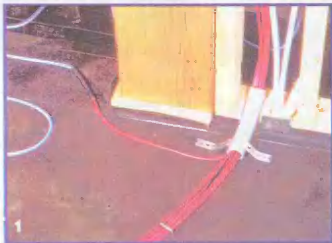
Проход через кабельный канал. По нормам электробезопасности требуется, чтобы концы нагревательных кабелей выходили из монолита через кабельный канал — в данном случае через пластиковую трубку Ø20 мм. По карману в стене кабели подходят к терморегулятору. На заднем плане можно увидеть соединение красного (не нагревающегося) и голубого (нагревающегося) кабелей
