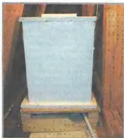
Для сохранения тепла нагретой воды бак укрыт пенопластом
