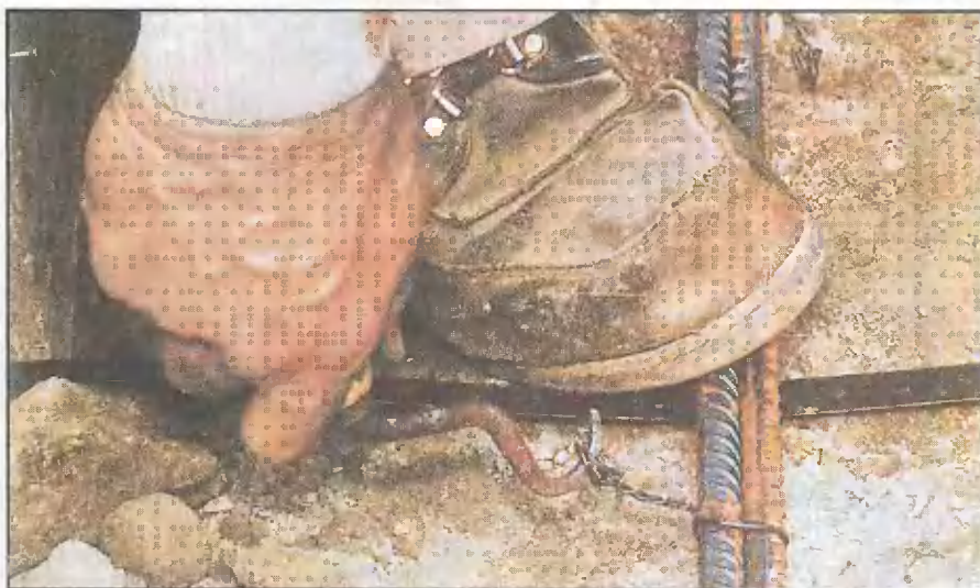
Проволоочные перевязки с петлями на концах закручивают вокруг стыка двух прутков перед заливкой раствора. Процесс ускоряется с помощью так называемой «крутилки» с деревянной ручкой. На длинных прогонах или при многочисленных изгибах перехлест прутков следует удлинить до минимум 36 диаметров и перевязать их в двух местах (фото справа)
