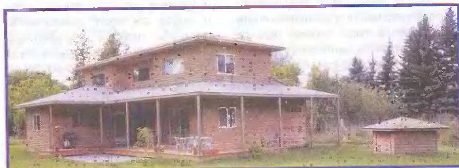
Подача свежего воздуха. Воздухозаборник с фильтрами расположен в маленьком «сарайе» на полянке недалеко от леса (от дома справа). После фильтрации воздух направляется в систему внутренней вентиляции
