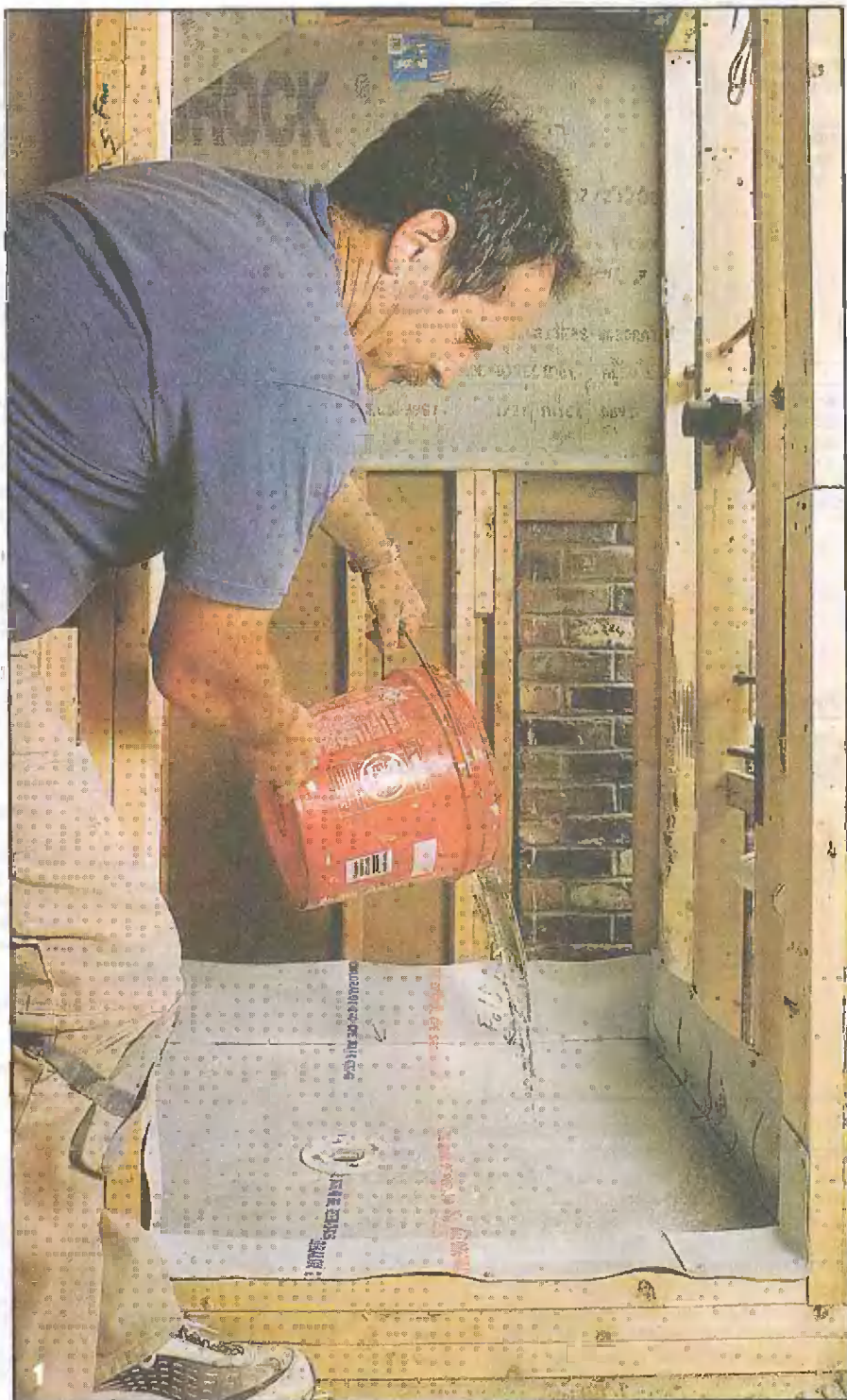
Идеальная проверка герметичности. Уложив пленку, нужно закрыть сток и залить поддон водой. Если есть протечка, то лучше обнаружить это сейчас, а не после приклеивания плитки
