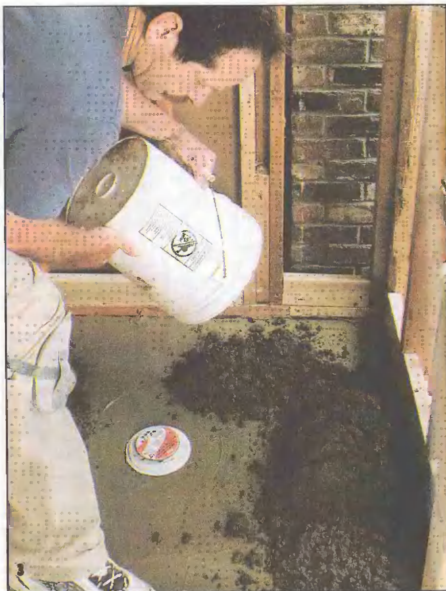
Формирование основания под пленку. Необходимо создать уклон в сторону стока в 6 мм на 300 мм длины
