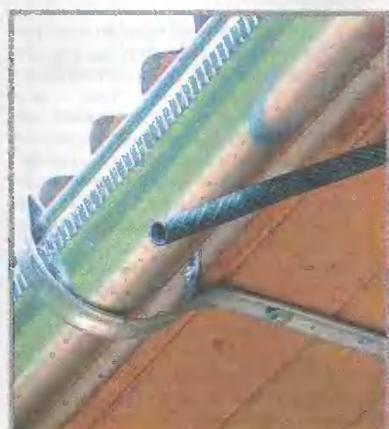
Переливная труба позволит избежать неприятностей
