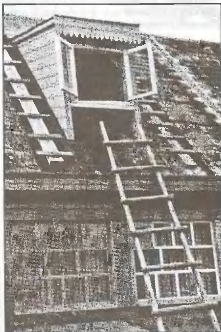
Каркас надстройки смонтирован
