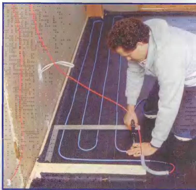
Тщательно следите за размерами петель. Каждый нагревательный кабель предназначен для своей комнаты. Точная длина и расстояние между петлями должны быть четко выдержаны. На фотографии видно, как автор крепит кабель специальным скобозабивным пистолетом
