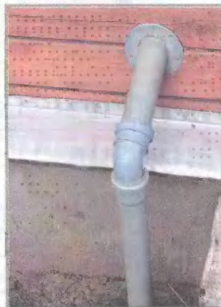
Сточная вода выводится в септик
