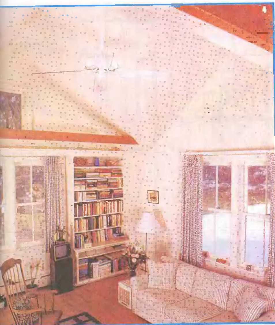
Кафедральный потолок. Каркас крыши позволил организовать кафедральный потолок. Открытые стяжки удерживают стены от распираия
