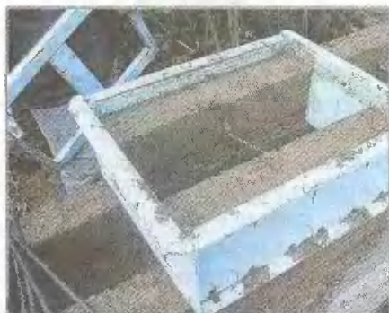
Формирование на стене блока без бетонных перемычек
