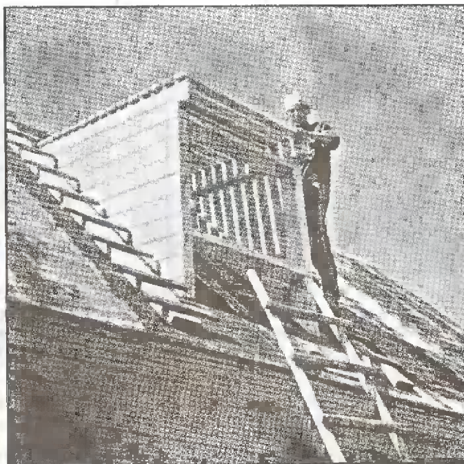
Доски обрешетки нарезаны в размер при сборке конструкции на земле
