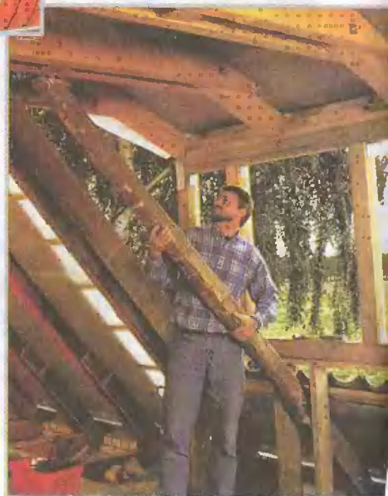
2 Стропила основной крыши частично удаляют после завершения монтажа каркаса окна
