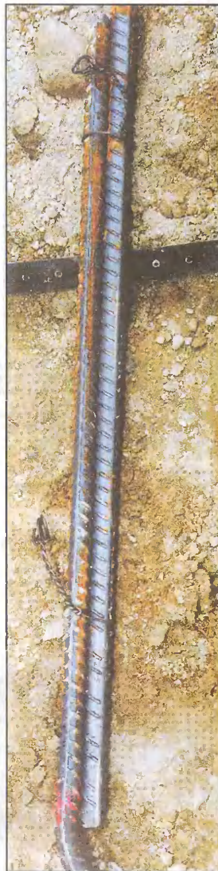
Проволоочные перевязки с петлями на концах закручивают вокруг стыка двух прутков перед заливкой раствора. Процесс ускоряется с помощью так называемой «крутилки» с деревянной ручкой. На длинных прогонах или при многочисленных изгибах перехлест прутков следует удлинить до минимум 36 диаметров и перевязать их в двух местах (фото справа)
