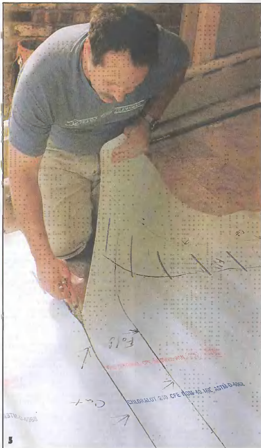
Разметка пленки. Со всех сторон не забудьте оставлять припуск в 180 мм. Лишь после этого начинайте резать
