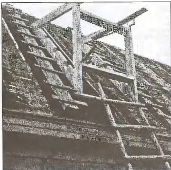
Для установки оконного блока вскрыта кровля мансарды
