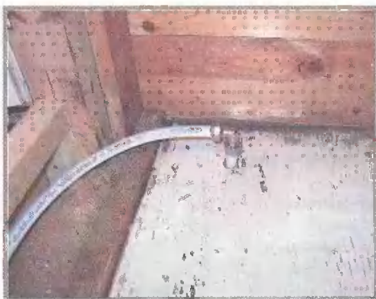
Через перекрытие труба уходит на кухню
