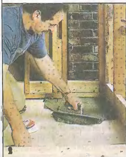
Поддон для душа начинается со слоя клеевого раствора, который следует наносить на очищенный черный пол
